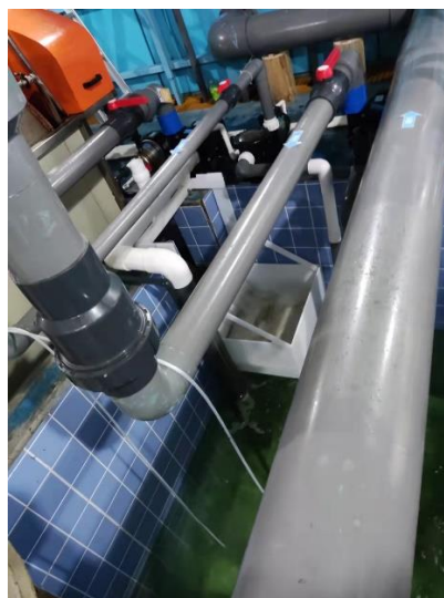
落沙井及缓冲池
