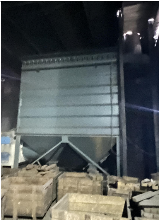
切割、打磨、落砂粉尘（布袋除尘）
