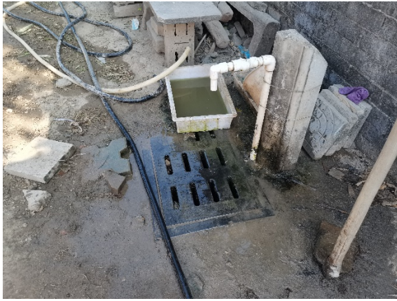
水管洒水降尘
