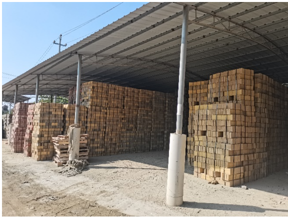
厂区地面硬化、成品堆棚
