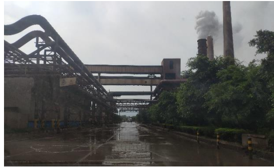
厂内道路洒水降尘设施
