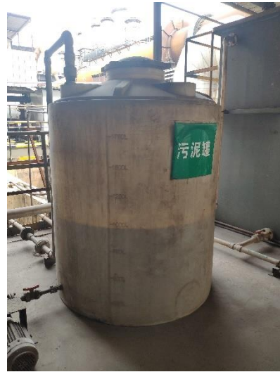
洗涤液收集处理设施
