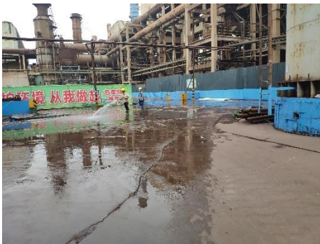
道路洒水降尘设施
