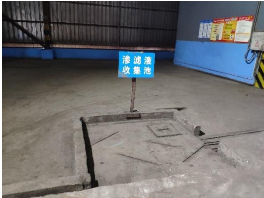
渗滤液收集池
