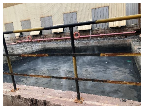
窑渣冷却水循环水池
