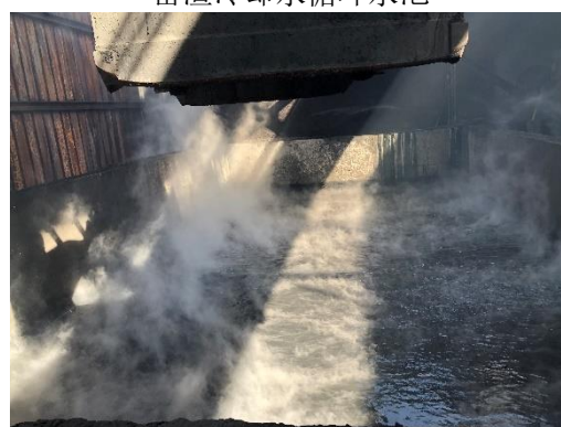
窑渣冷却水循环水池
