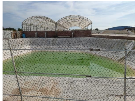
南面初期雨水收集池
