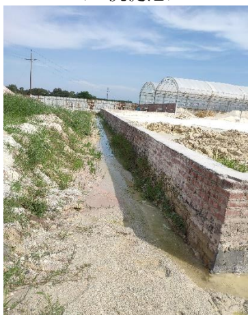
南面初期雨水收集沟
