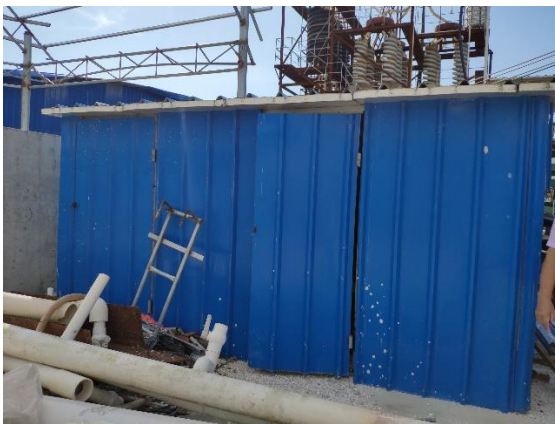
破碎机隔音房
