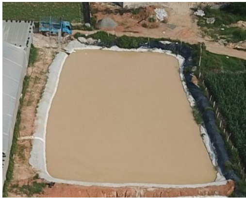
西南面初期雨水收集池
