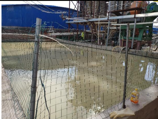
6#石英砂生产线废水沉淀池
