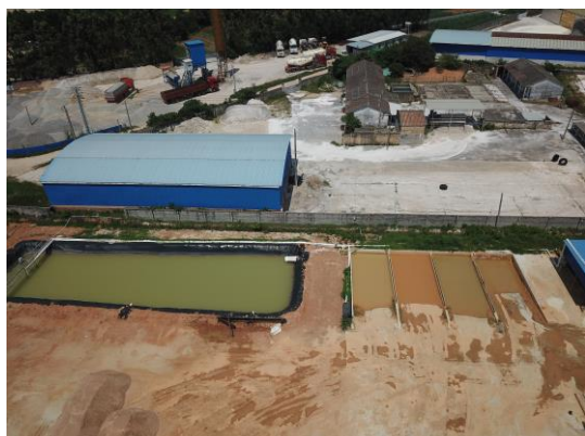
初期雨水收集池及四级沉淀池
