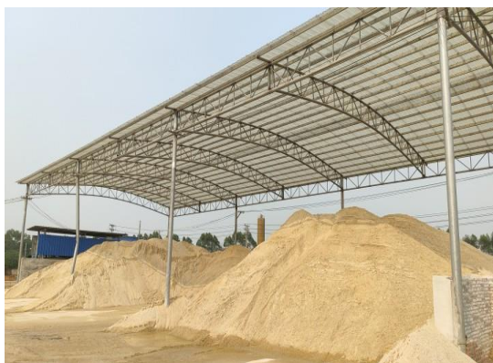
中间仓库加盖顶棚
