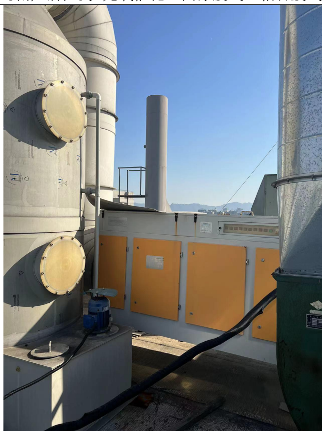
水喷淋+光氧催化+活性炭（面漆废气（备用））
